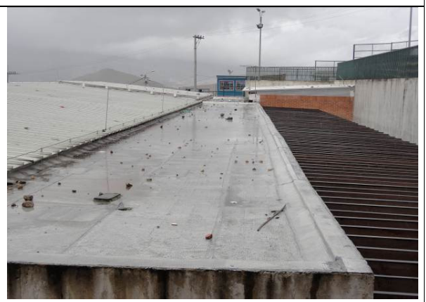
Cubierta de preescolar con deficiente mantenimiento
