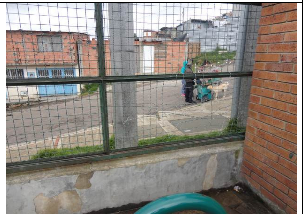
Malla entrada parqueadero deteriorada
